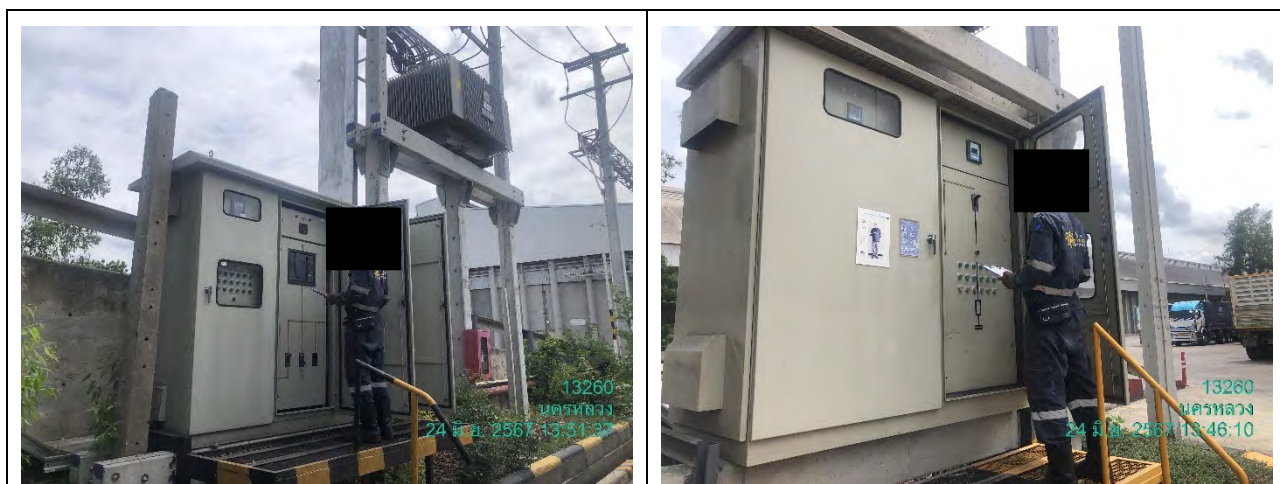
รูปที่ 2.2-42 การตรวจสอบ บำรุงรักษาไฟฟ้าแสงสว่างบริเวณท่าเทียบเรือ
