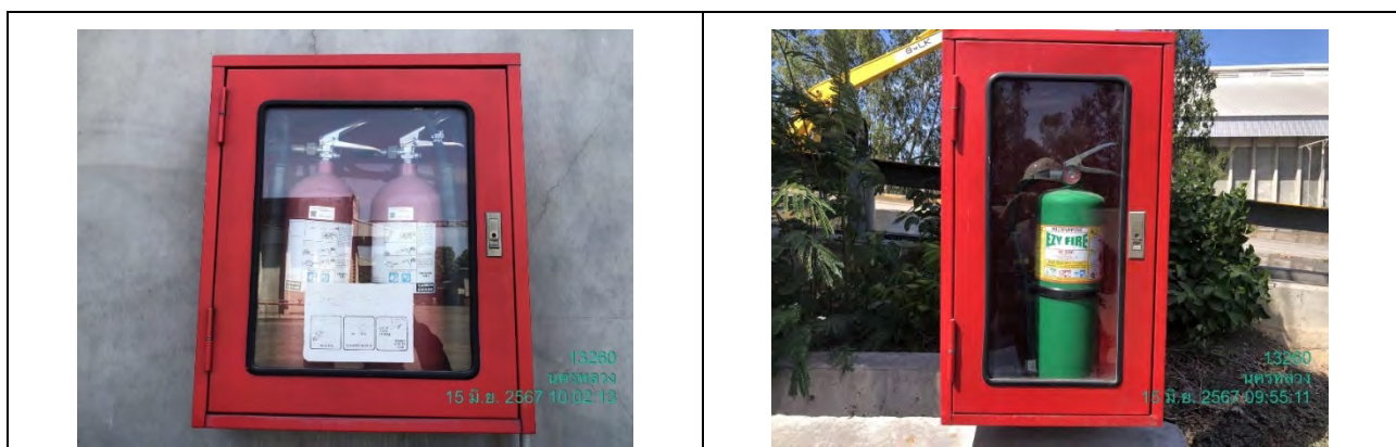
รูปที่ 2.2-73 ถังดับเพลิงชนิดผงเคมีแห้ง ขนาดบรรจุ 10 ปอนด์ ถังดับเพลิงชนิดก๊าซคาร์บอนไดออกไซด์ ขนาด 10 ปอนด์ และถังดับเพลิงชนิดน้ำยาเหลวระเหย (BF2000) ขนาด 10 ปอนด์
