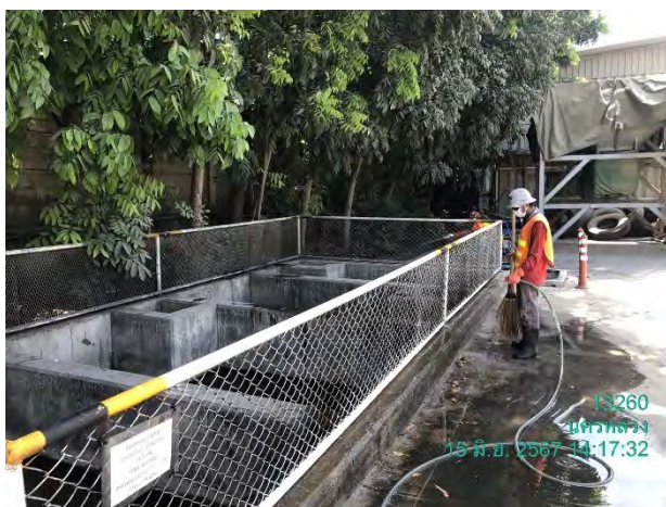
รูปที่ 2.2-21 การทำความสะอาดรางระบายน้ำ และบ่อดักตะกอนภายในโครงการ
