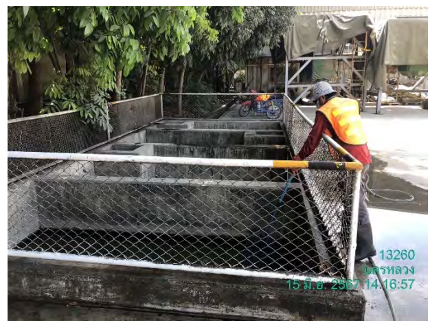
รูปที่ 2.2-21 การทำความสะอาดรางระบายน้ำ และบ่อดักตะกอนภายในโครงการ
