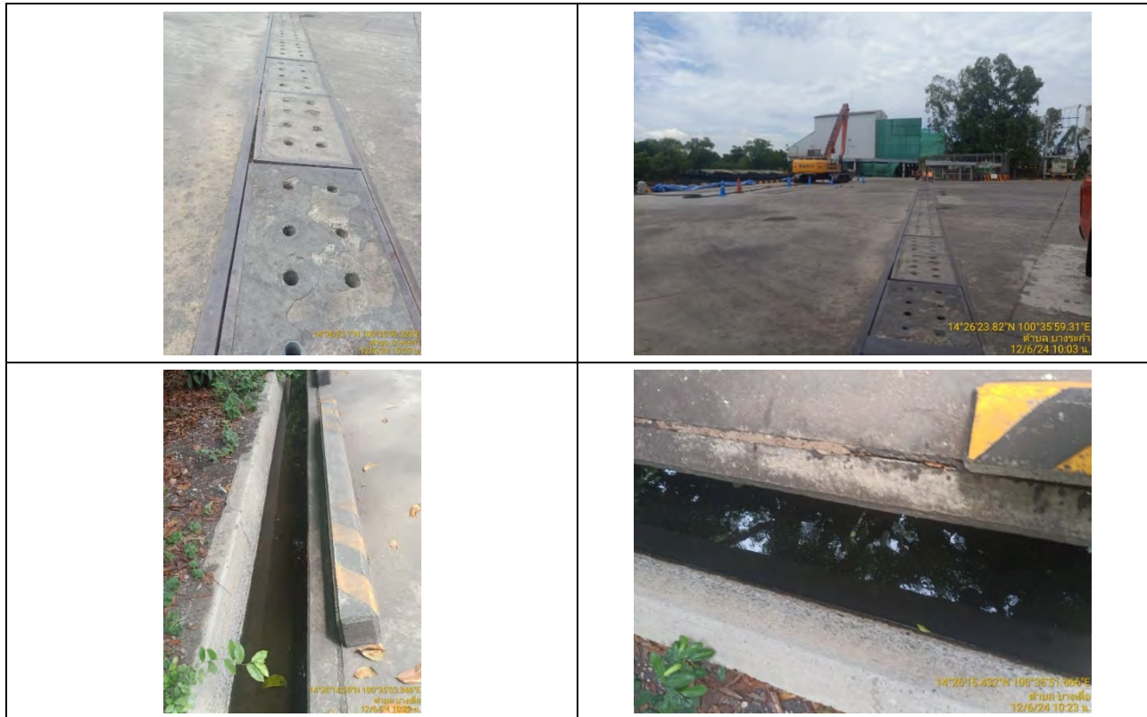
รูปที่ 2.2-49 ระบบระบายน้ำและการทวน้ำด้วยรางระบายน้ำ ของโครงการ
